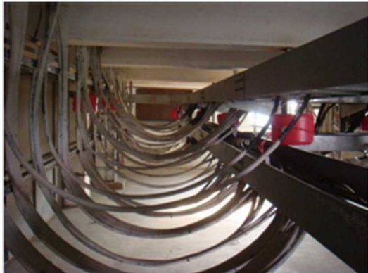
天津国华电厂电缆沟（悬挂胀裂式）
