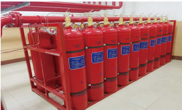
山东中华发电有限公司聊城发电厂1301改造工程（管网式）
