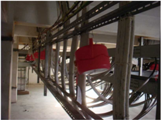
天津国华电厂电缆沟（悬挂胀裂式）
