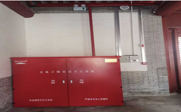
潍坊城隍庙文物工程（管网式）
